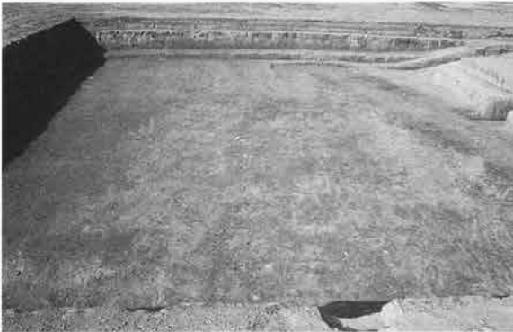
3. III区4面調査状況
