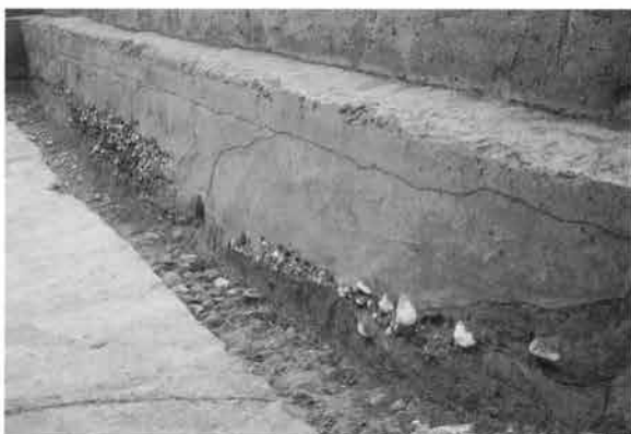
矢部5区深掘トレンチ西壁 東
