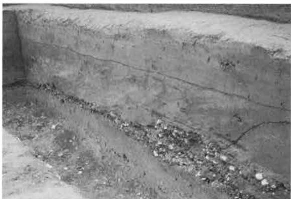
矢部5区深掘トレンチ西壁 東
