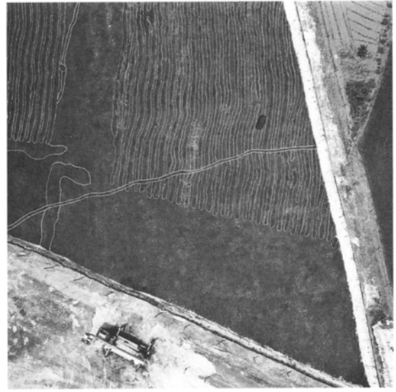
Ⅲ区-Dブロック 全景
