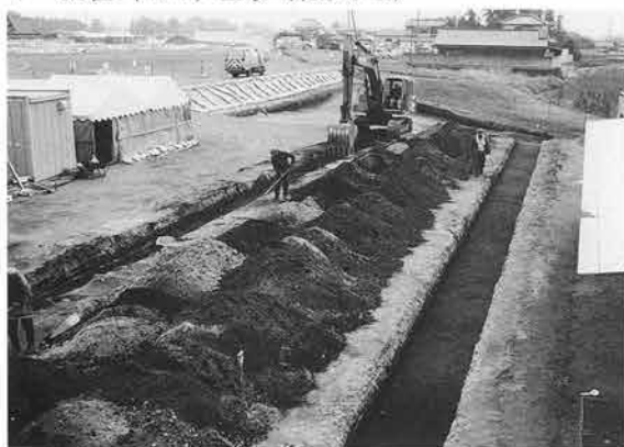
2 60区 (no49) 調査状況
