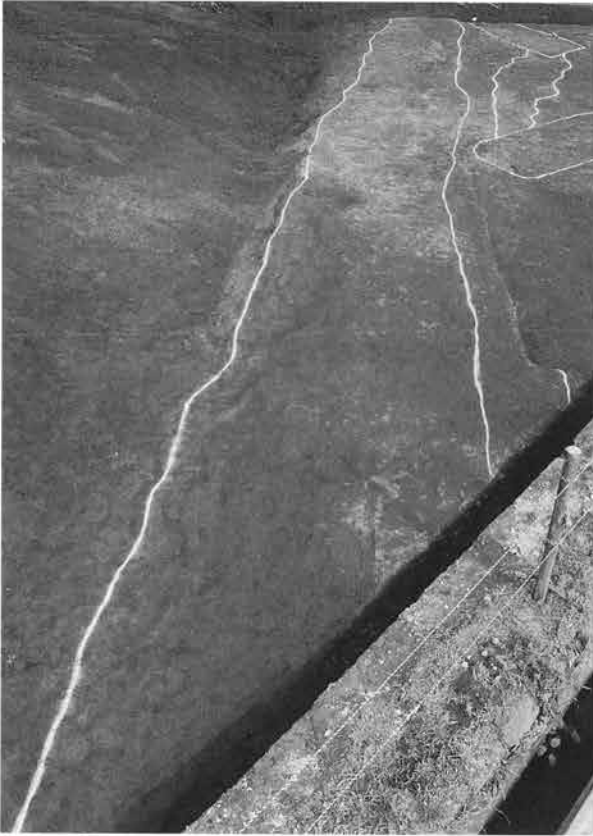
道9(新) 北西から
