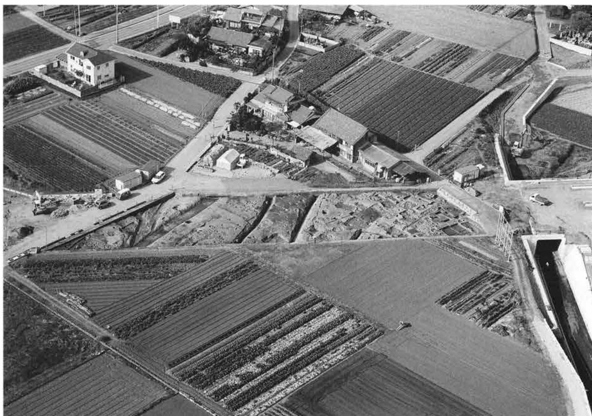
R区全景 東から
