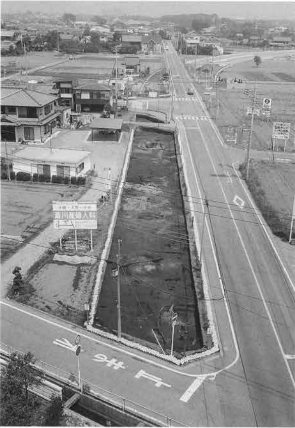
N西区全景 南から
