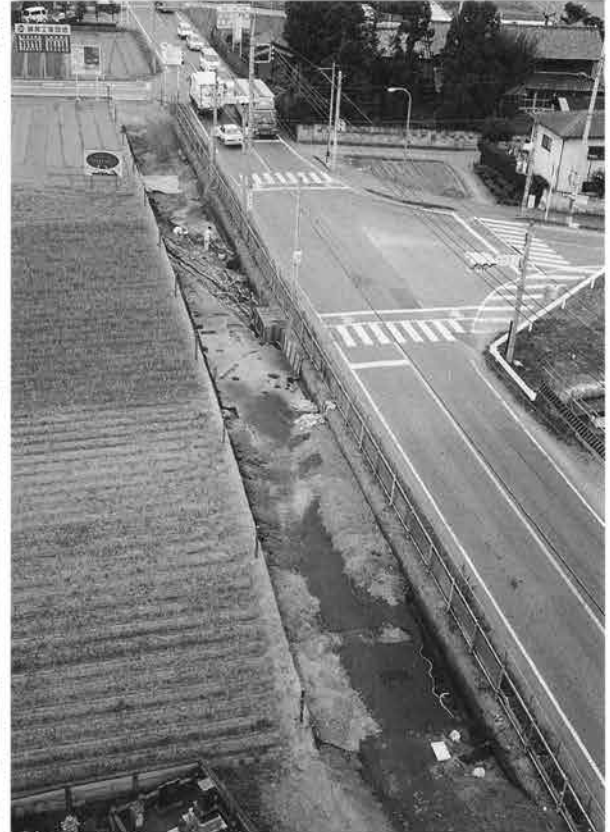
○東区全景 北から
