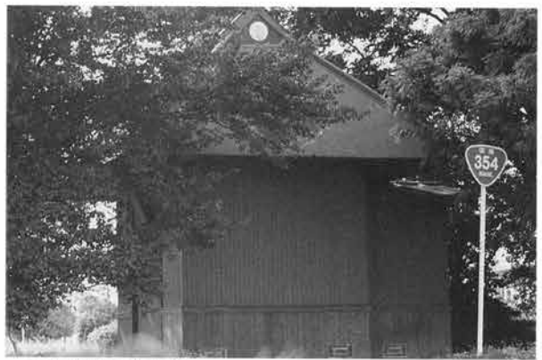
諏訪神社解体直前 東から
