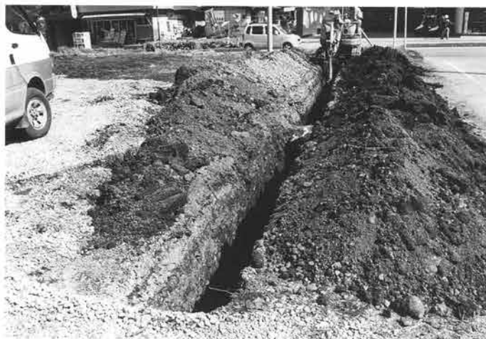
2 I区東側トレンチ掘削状況（北から）
