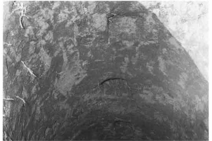
4 3号井戸足場の痕跡
