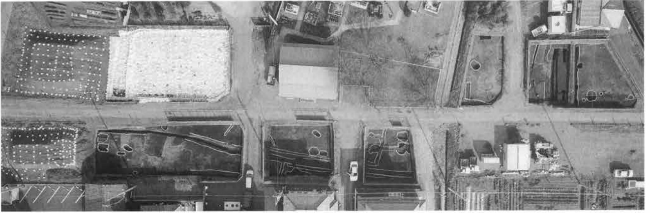
A区全景 (南上空から)
