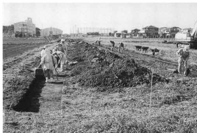
H区トレンチ調査状況（東から）
