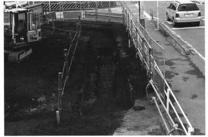
C-4区古墳時代～奈良平安時代面 全景 東から
