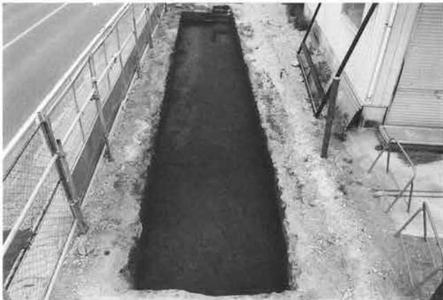
D-9区古墳時代～奈良平安時代面 全景 東から
