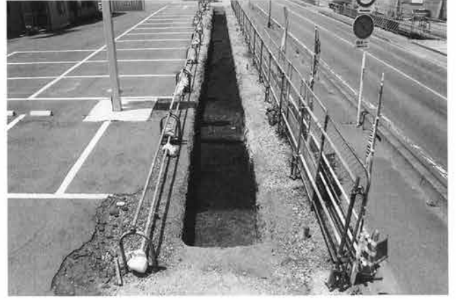
C-2区古墳時代～奈良平安時代面 全景 東から
