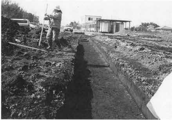
試掘中央東トレンチ
