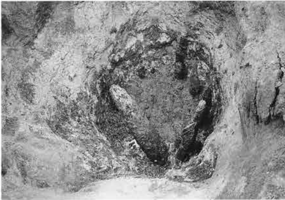
B 1-18井戸木杭打設状況 (南より)
