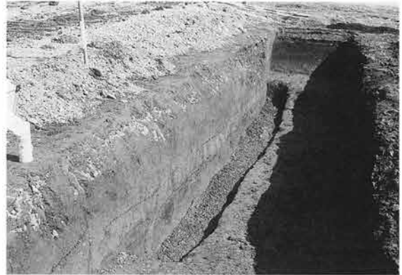
試掘中央東トレンチ
