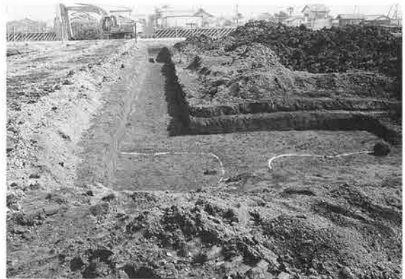
試掘中央東トレンチ
