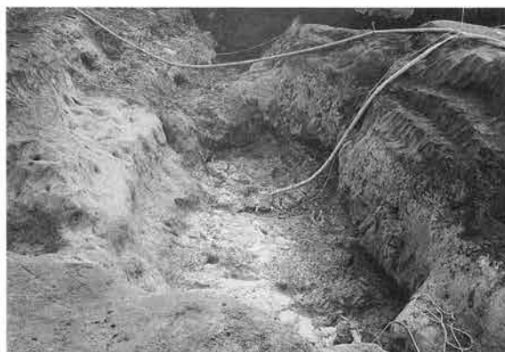
B区2面谷地 (西より)
