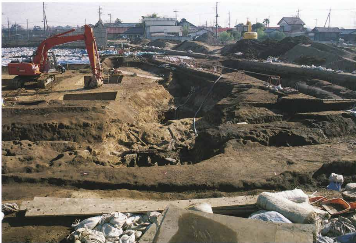
B2-谷遺構全景（西より、手前側に堰跡らしき木材の出土が見られる）
