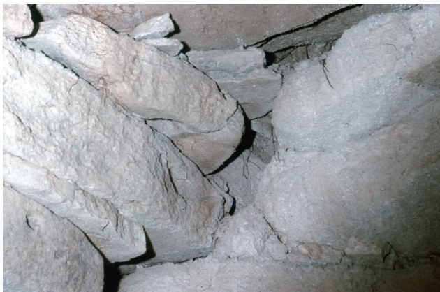
写真7 天井部付近の石積み
