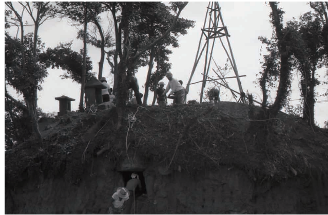
写真4 調査風景（西より）
