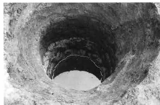
B区34号井戸完掘状況
