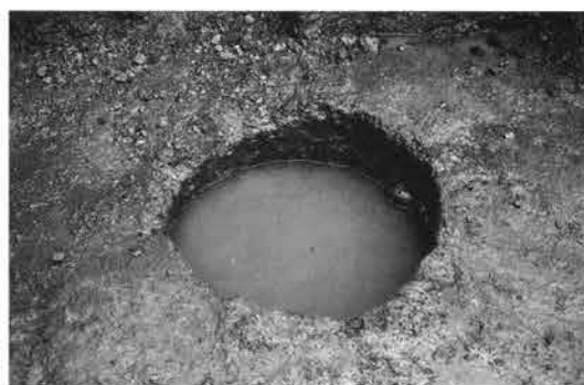
A区24号井戸湛水状況
