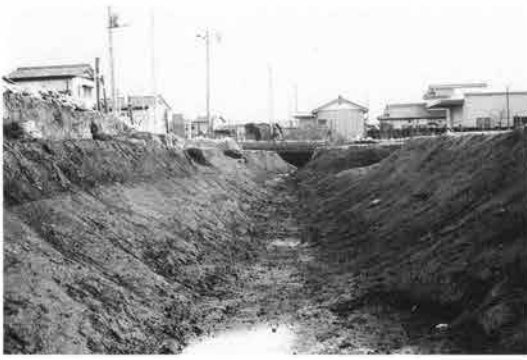
B区24号溝断面形状 (北から)
