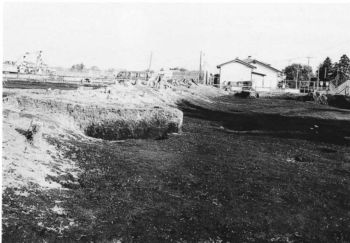
D区屋敷跡外土塁全景
