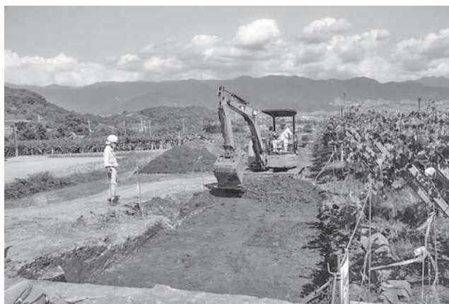
③区下段 表土掘削 西から
