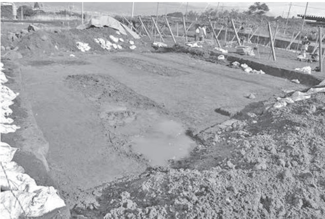
①区 T3 遺構検出状況 西から
