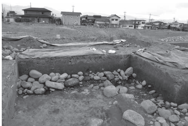
TR11 SD35 南壁 北から
