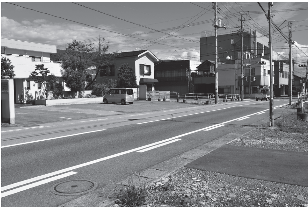
⑧区着手前状況(南西から)
