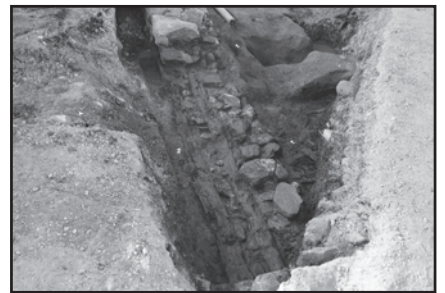
D 地点 SS1 東側 胴木敷設状況(東から)
