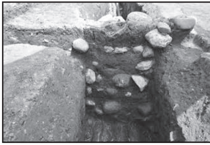
⑤区 SD1 構築状況(南から)
