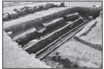
⑤区 SS1・SS2 桐木敷設状況(西から)
