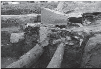
⑧A区 SS1 構築状況(南から)
