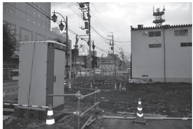
調査前現況（南から）
