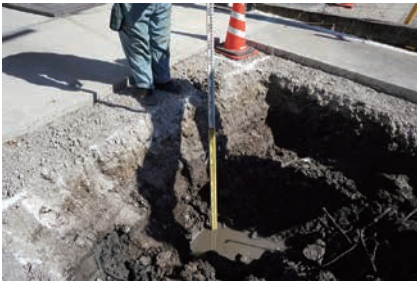
I地点 深掘り確認状況 西から
