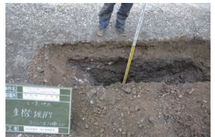
C-3 地点東トレンチ 重機掘削状況 南から
