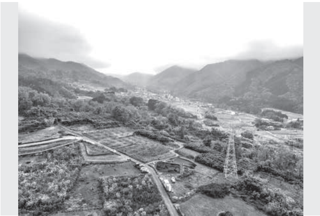
遺跡近景（奥は浅川の谷筋：若彦路）上空北から
