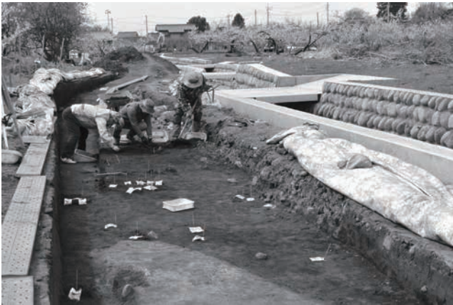
遺物包含層掘削 遺物検出作業風景 北から
