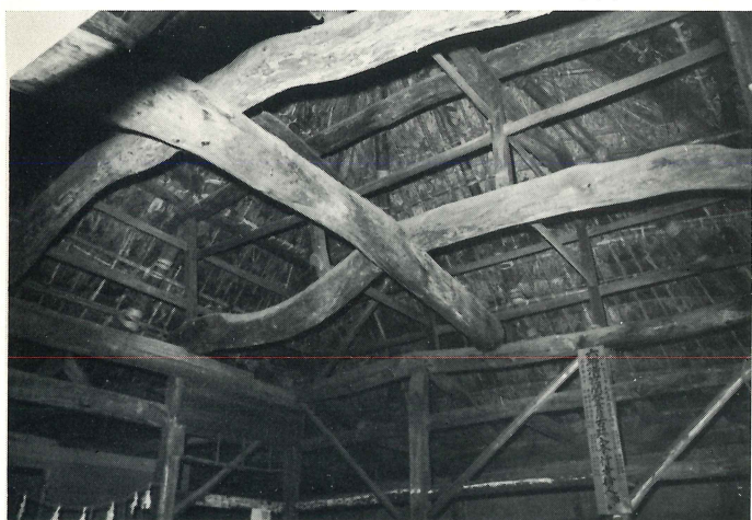
写真13 智恩寺講堂屋根裏
