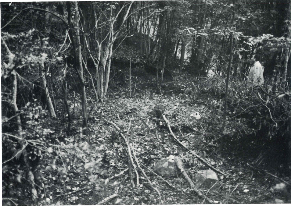
本殿跡(人物の前方)
