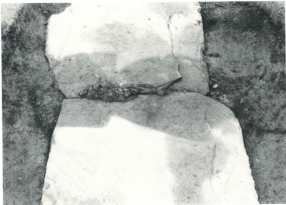
1号主体部目貼り状態
