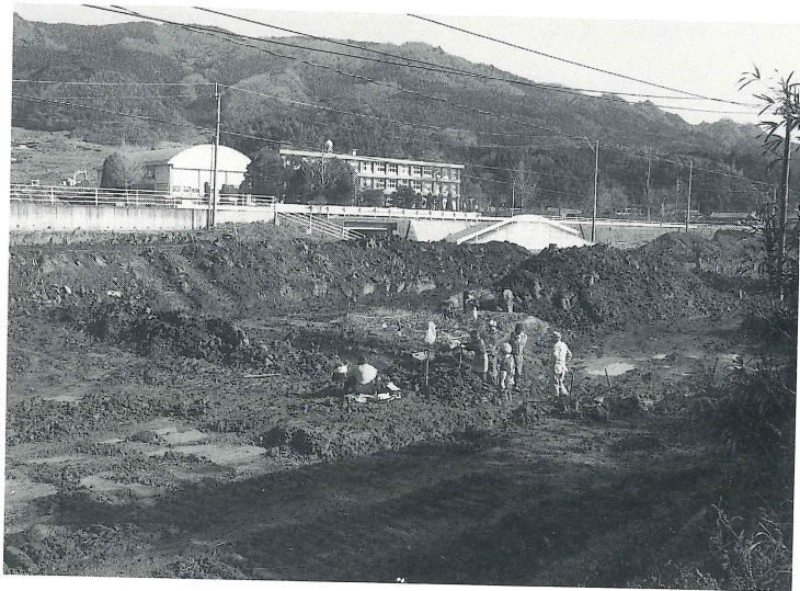
調査区近景（南西）より
