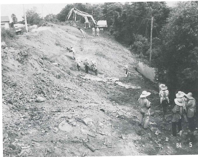
ユンボによる表土剥ぎと遺構確認
