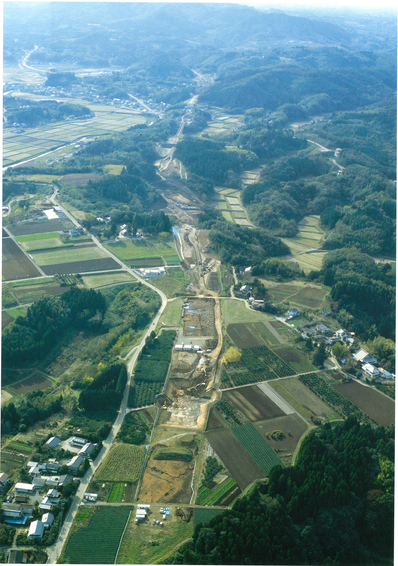
中九州道予定地遠景（高添遺跡より西を望む）
