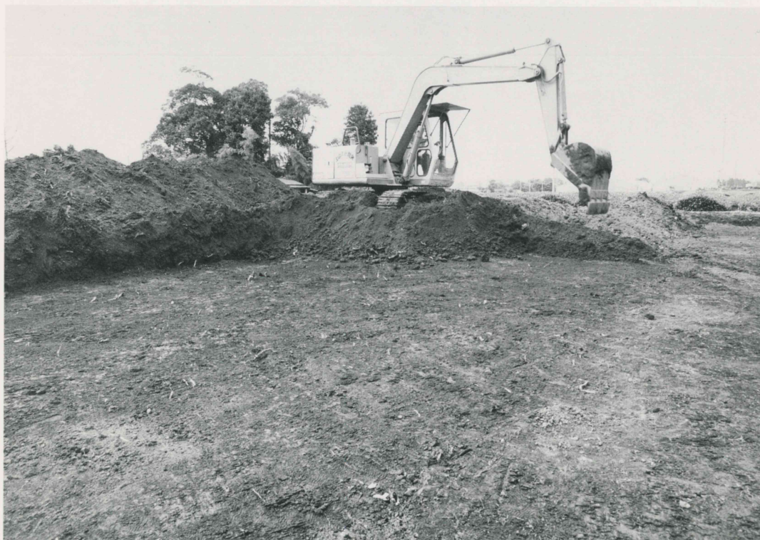
重機作業風景
