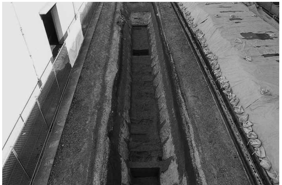
(3) 第2トレンチ全景(西から)
