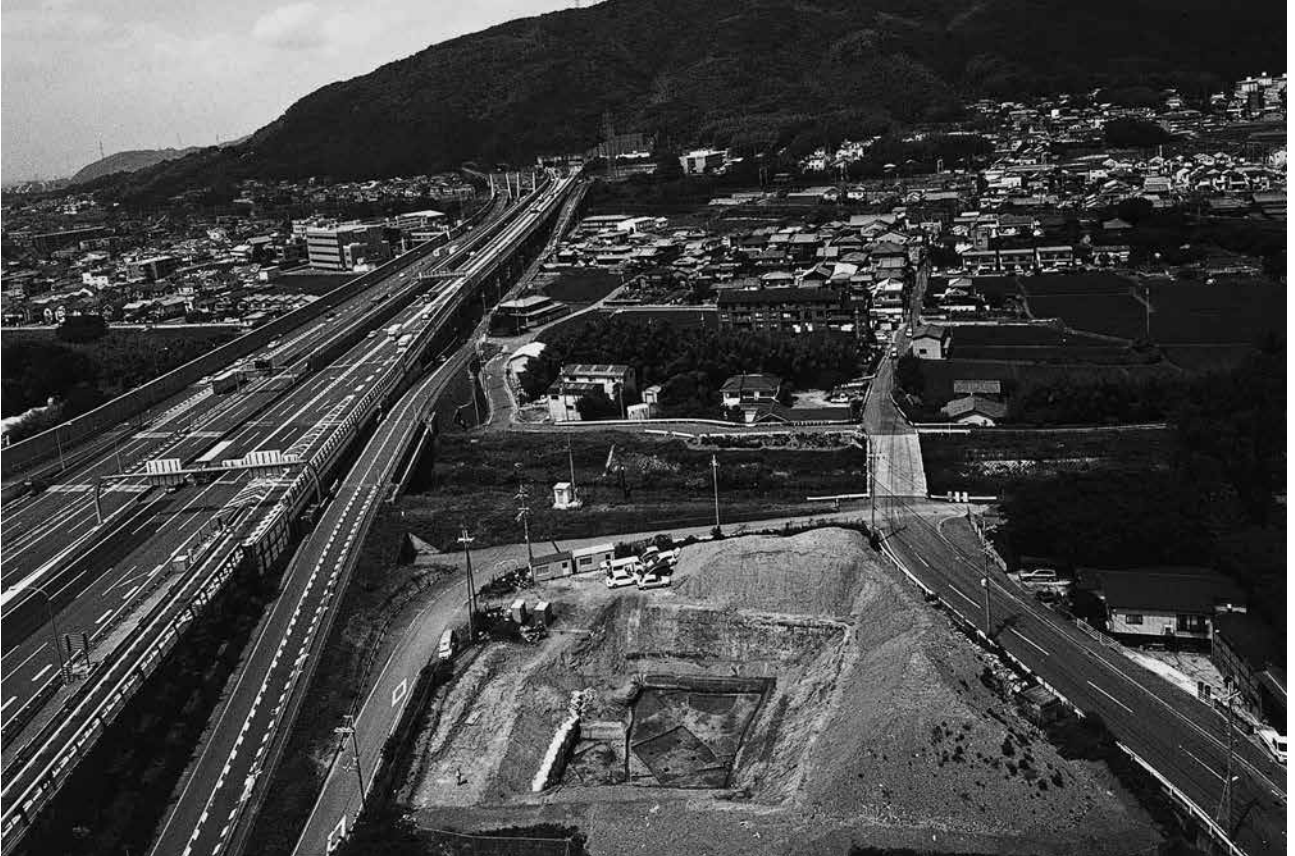
(1) 調査地全景(北東から)
