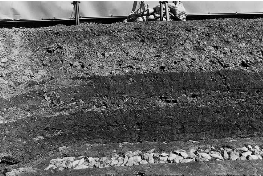
(2) 土層堆積状況(北西から)
