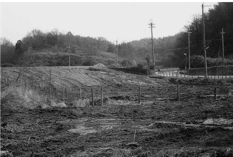
(3) 埋め戻し作業状況(北西から)
