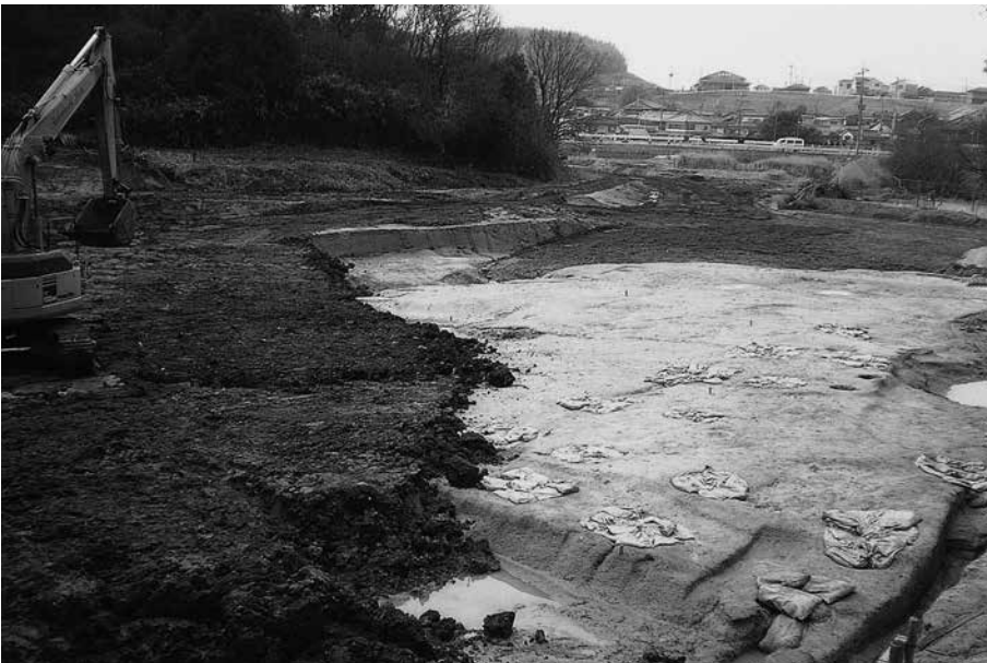
(2) 埋め戻し状況(北東から)
