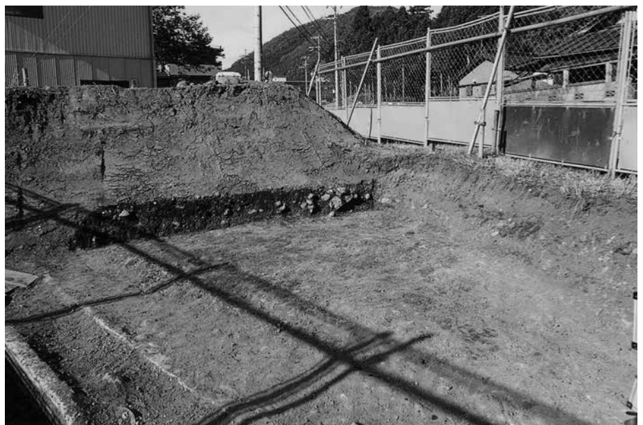
(3) 1 トレンチ土層断面(南西から)
