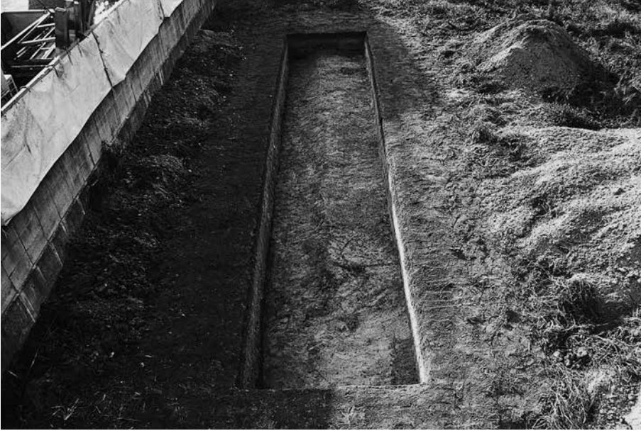
(1) C地区3トレンチ全景(西から)
