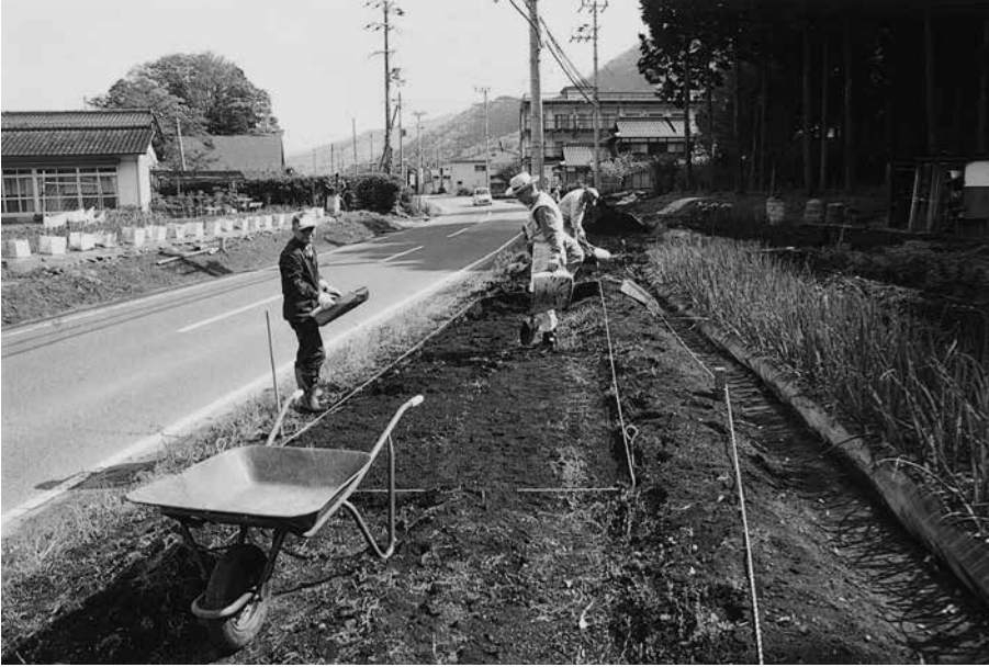
(1) 2区作業風景(南西から)
