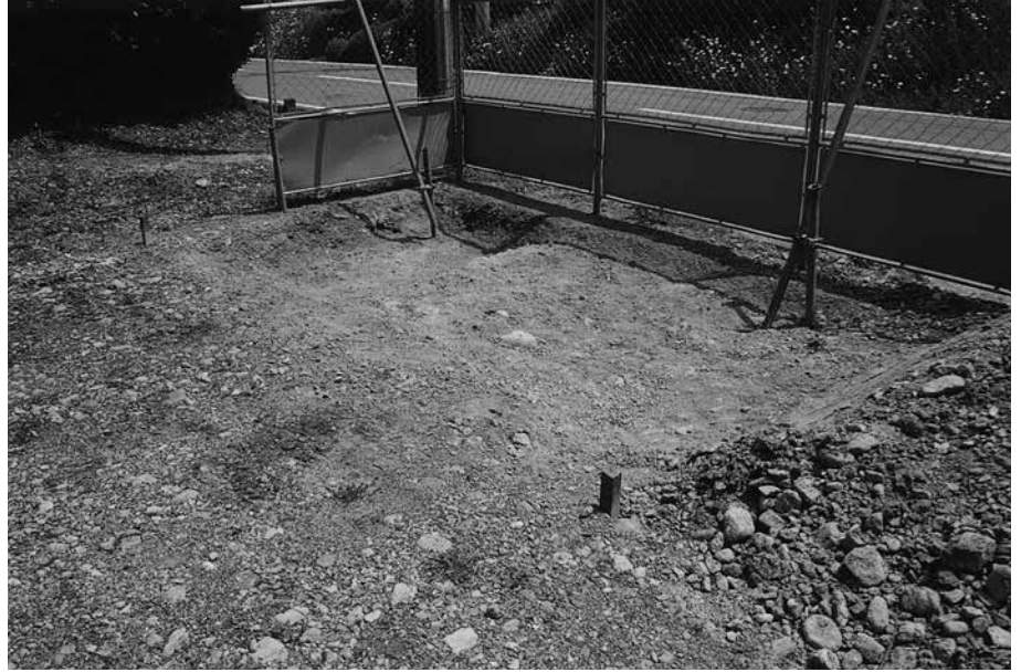
(1) 4-2 トレンチ全景(南西から)
