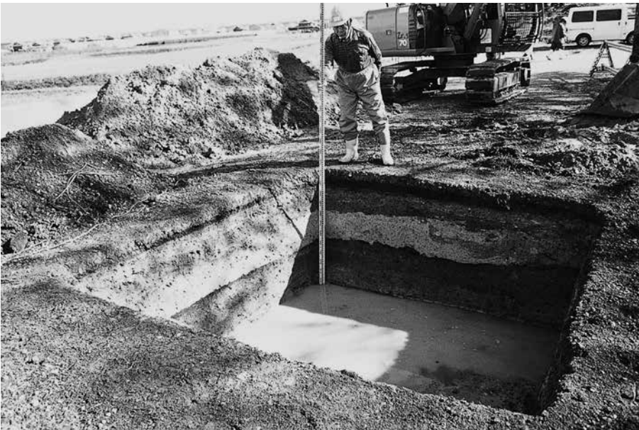
(2) G地区掘削状況(北西から)
