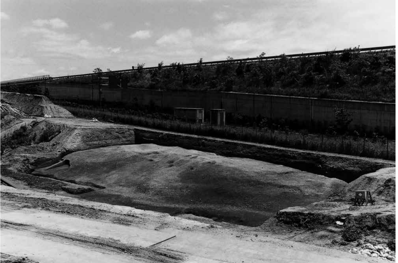
(1) 第12次調査全景(表土掘削後：南西から)
