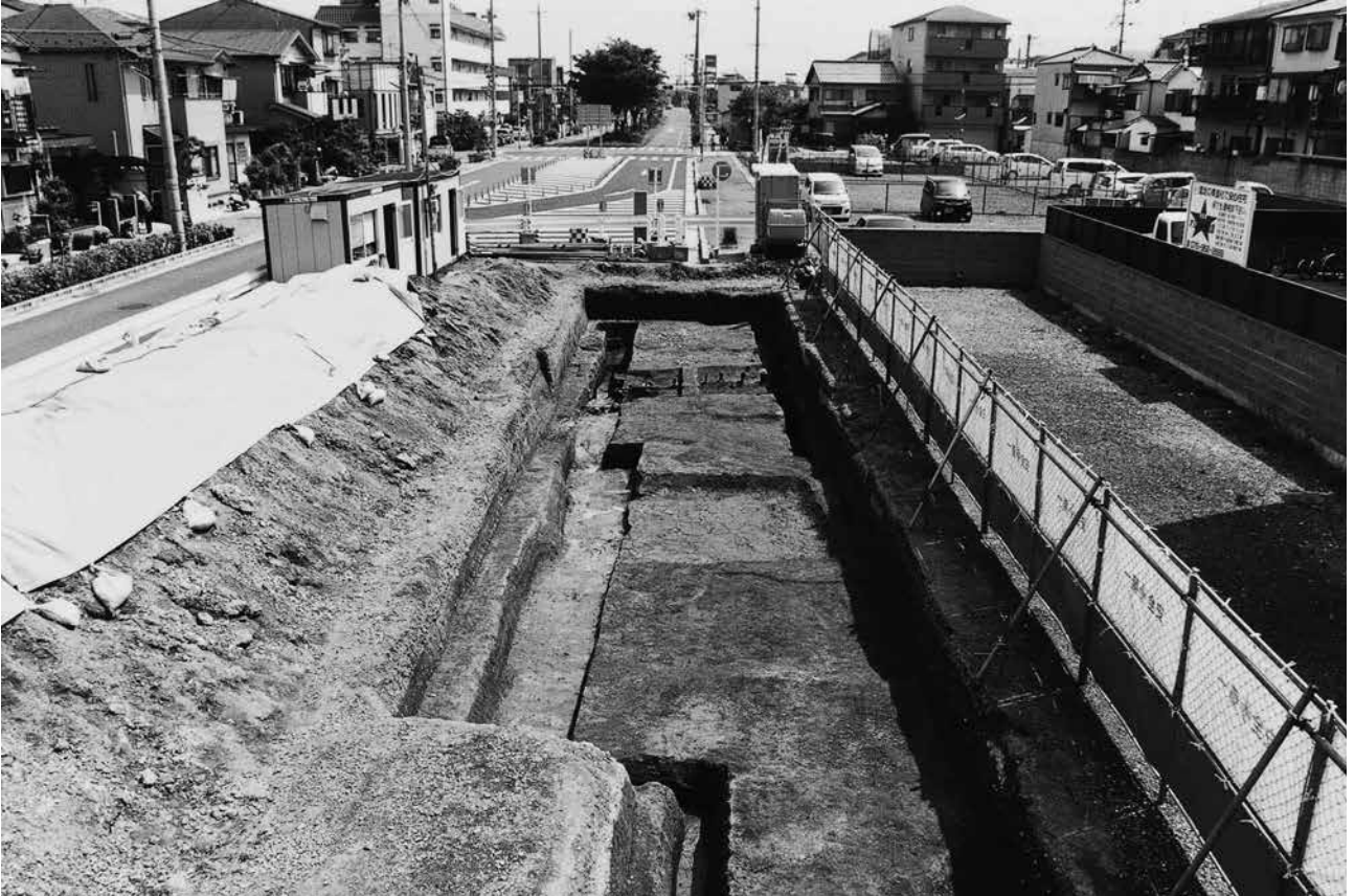
(1) 調査区全景<上層> (北から)
