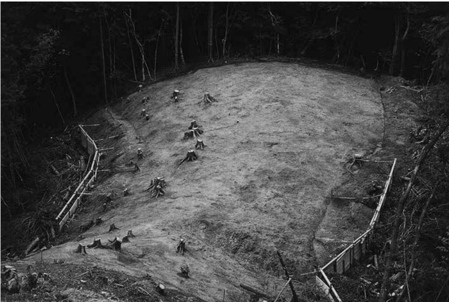
(2) C地区掘削状況(南西から)
