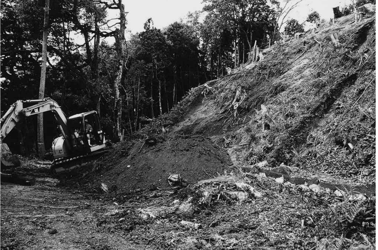
(1)切岸2掘削状況(南から)
