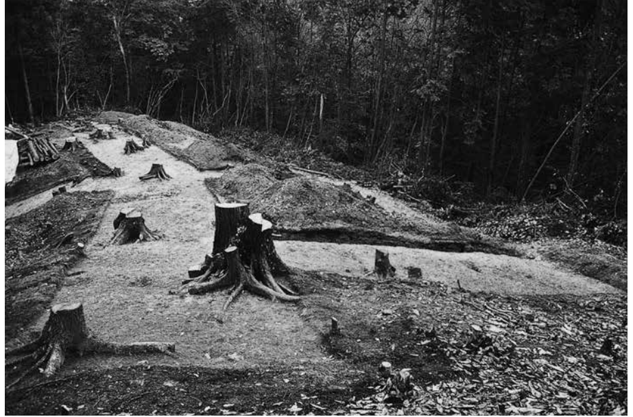
(1) B 地区掘削状況(南西から)
