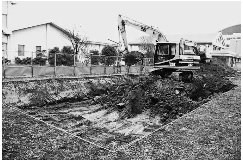
(2) Bトレンチ重機掘削(南東から)
