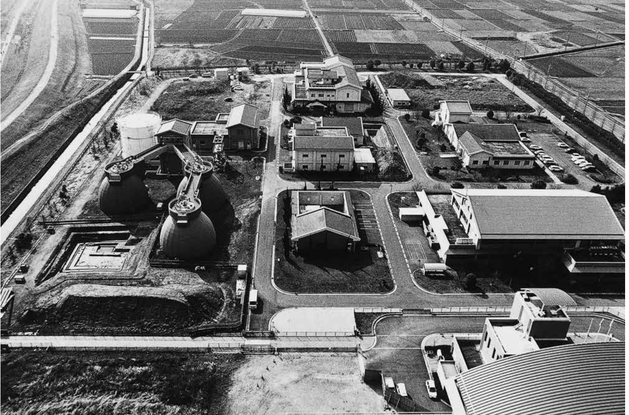
(1) 調査地遠景(北から)
