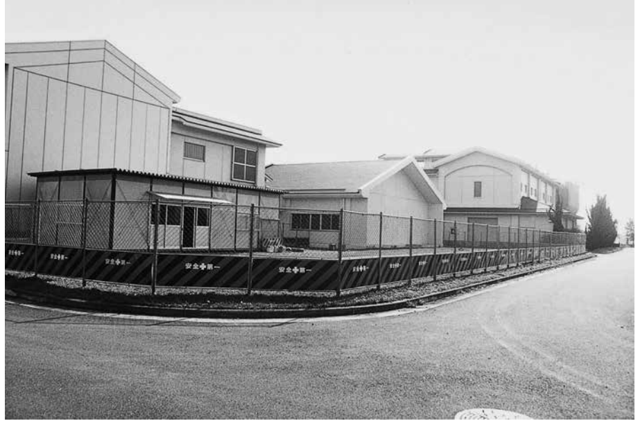
(1) Bトレンチ調査前(北西から)
