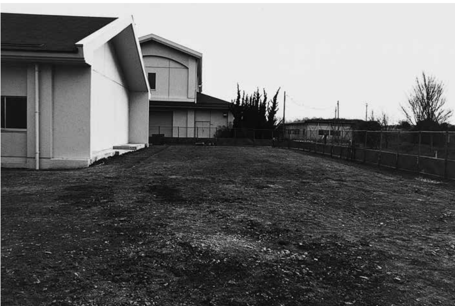
(3) Bトレンチ埋め戻し終了 (北から)
