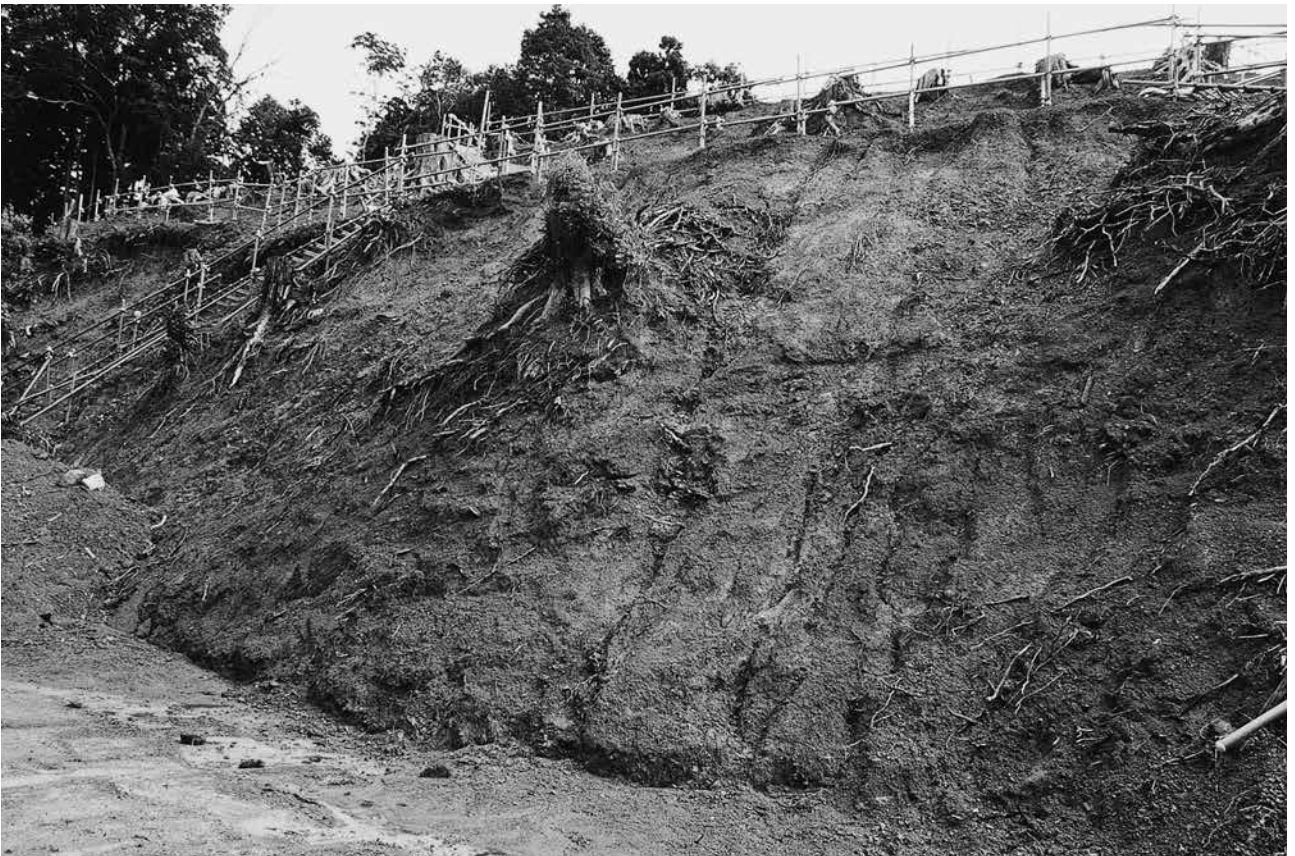
(2)切岸2南部(南西から)
