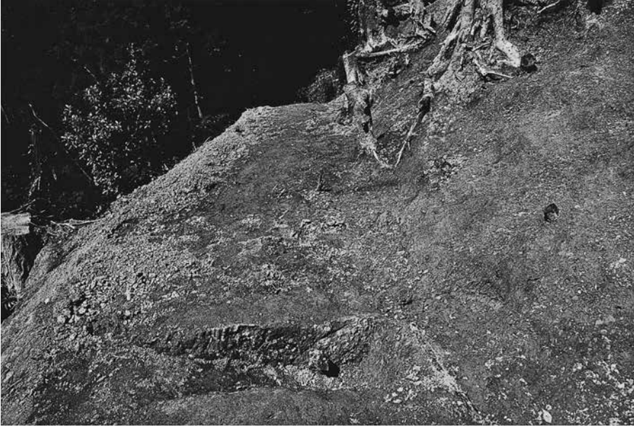
(1) 切岸1と郭1-2との断ち割り (南から)
