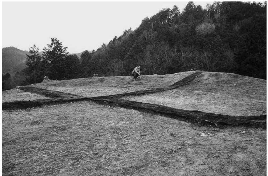
(2) A地区曲輪掘削状況(北から)
