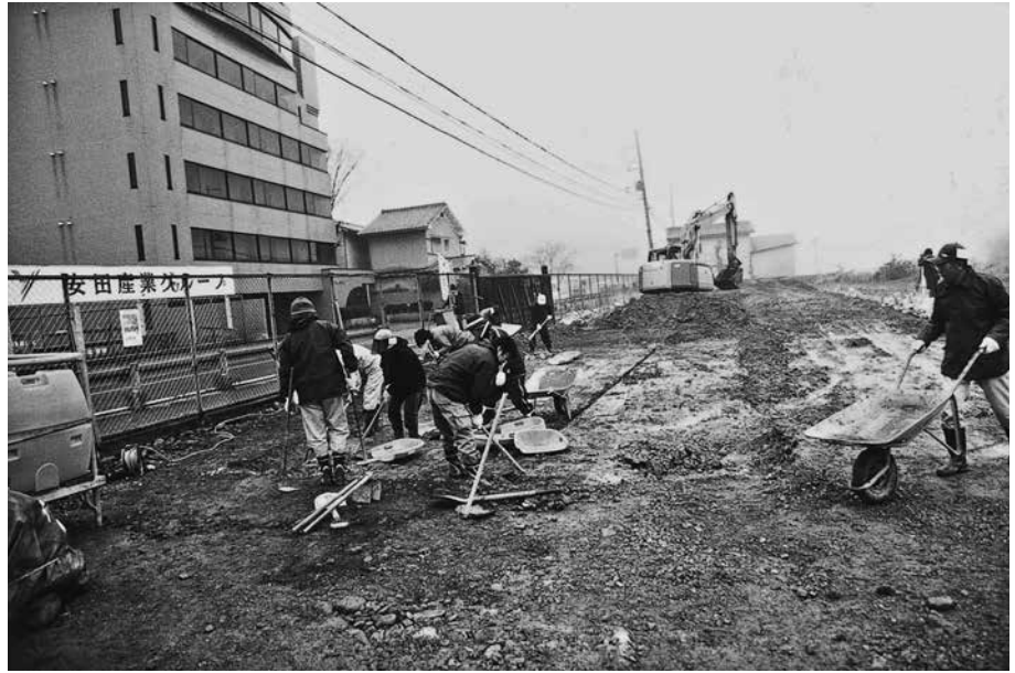
(1) 第2トレンチ荒掘り状況 (東から)
