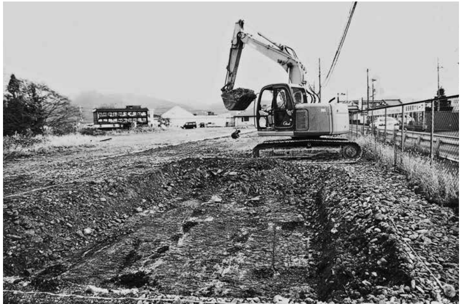
(2) 第 1 トレンチ重機掘削状況 (西から)
