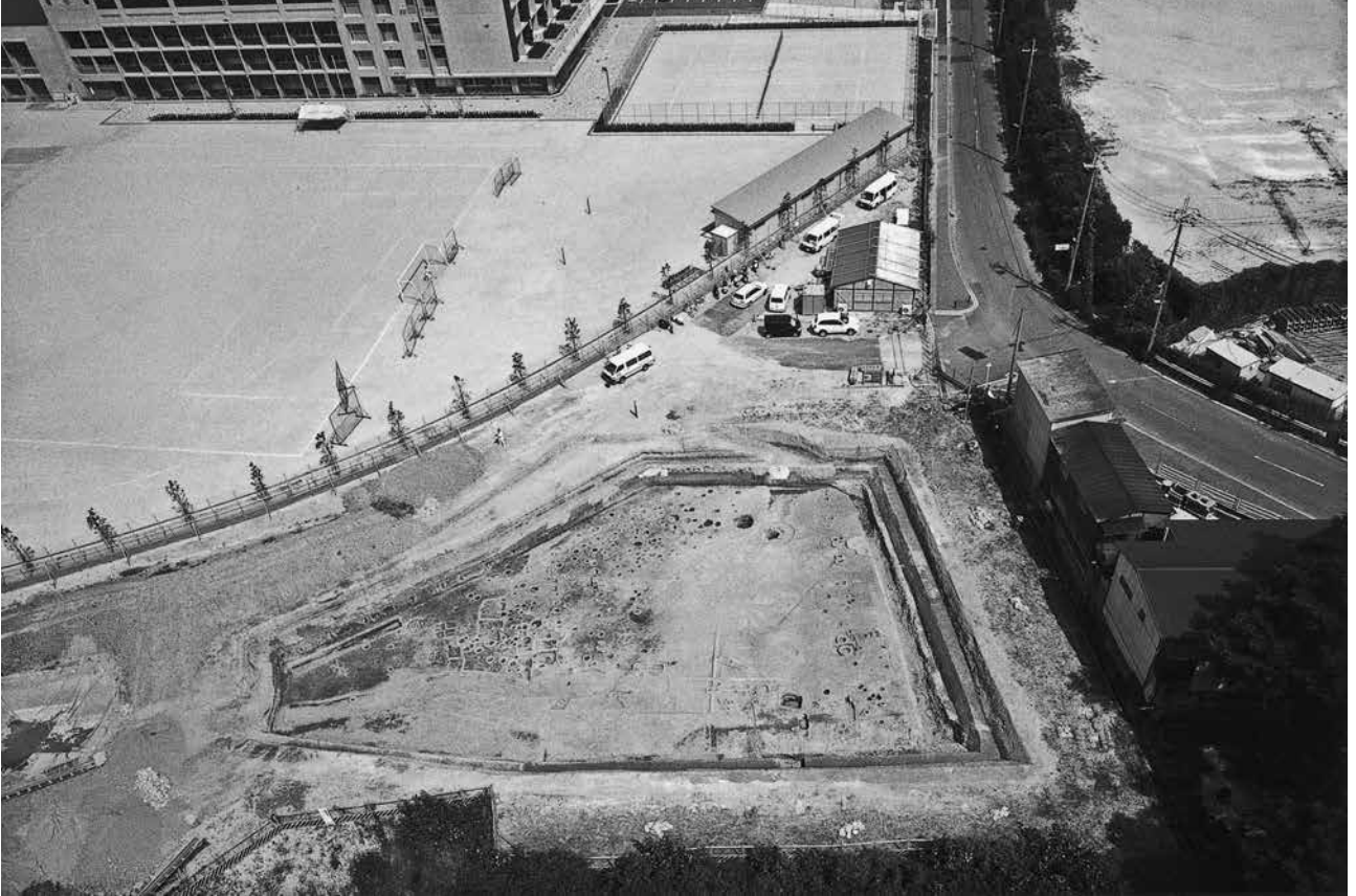
(1)松田遺跡調査地全景(西から)
