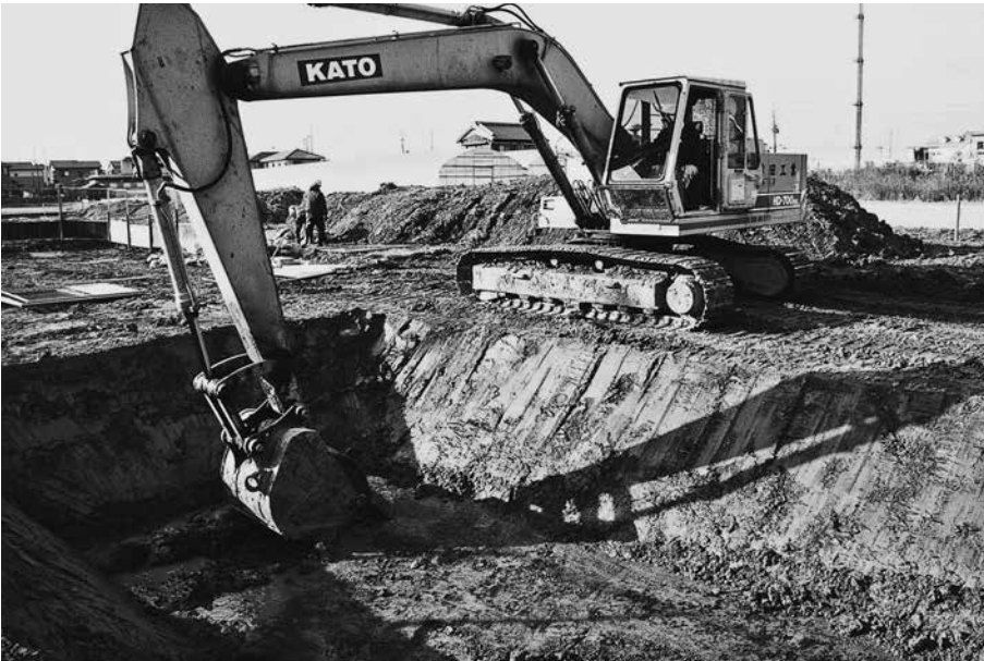
(2) 第6トレンチ重機掘削作業 (北東から)
