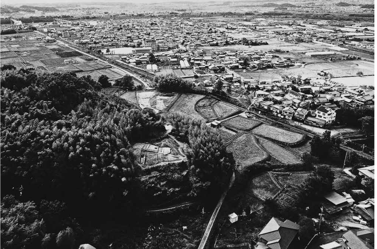
(1) 調査地遠景(北から)
