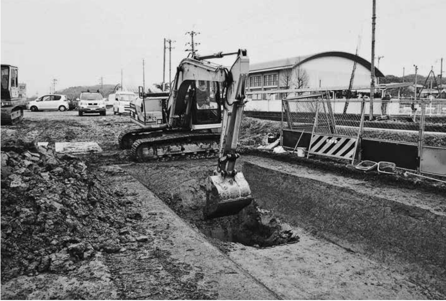
(1) 第8トレンチ断ち割り作業 (南西から)
