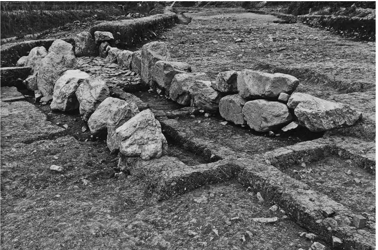
(2) 国分61号墳石室構築状況(南西から)
