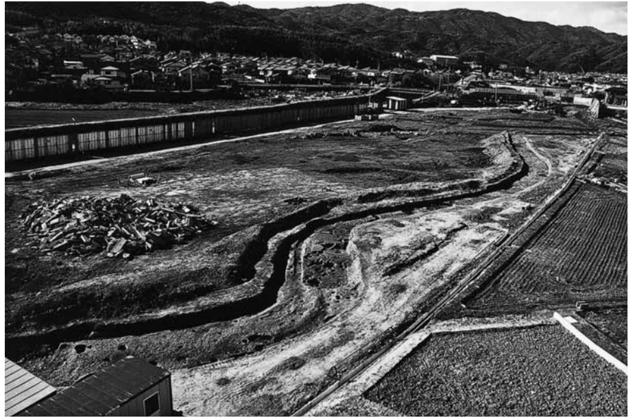
(1) 1 トレンチ全景(南東から)
