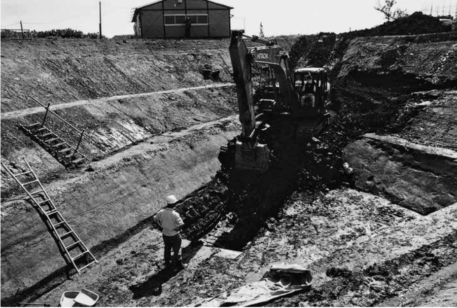
(1) 重機による深部掘削状況 (北西から)
