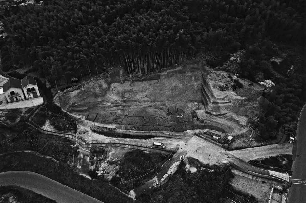
(1) 高山Aトレンチ全景(南東から)
