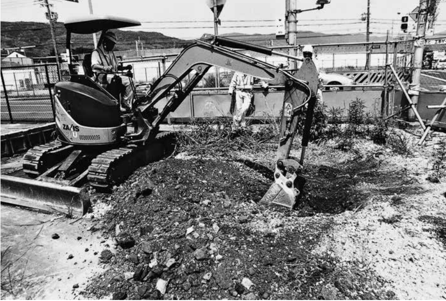
(1) d 2 地区重機掘削状況 (南東から)
