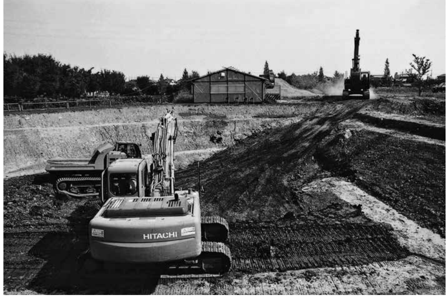
(1) 重機による表土掘削・ 除去作業の状況(西から)
