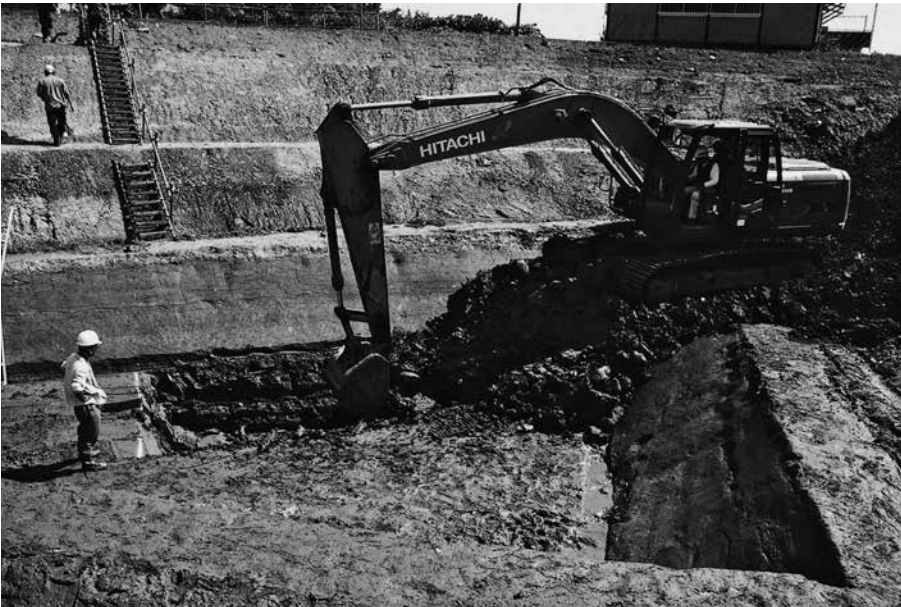
(2) 重機による深部掘削状況 (西から)
