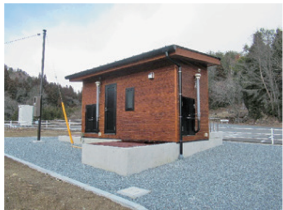
トイレ完成（背面）
