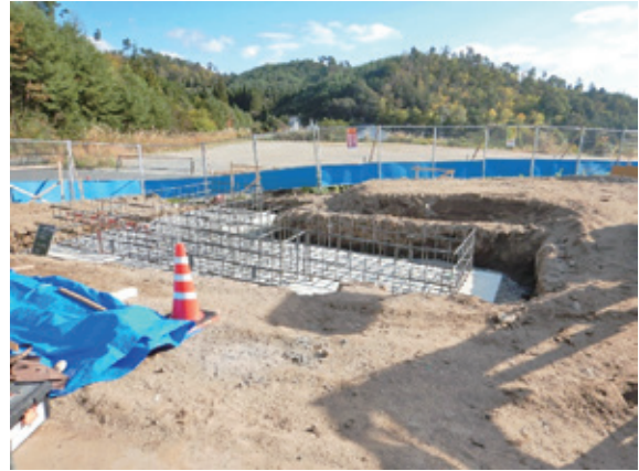
トイレ基礎工事
