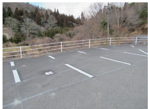
駐車線区画線完成 2
