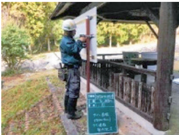
サイン取付工事 3
