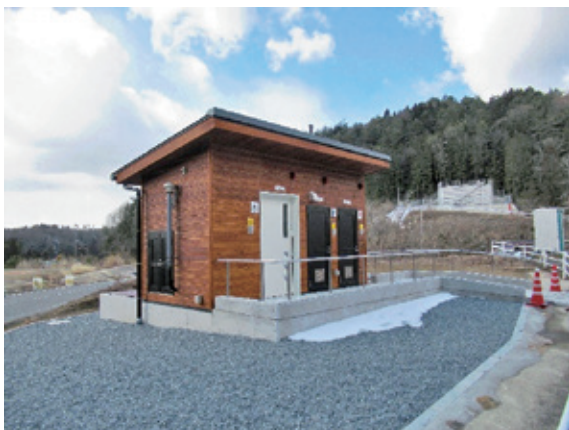
トイレ完成（前面）
