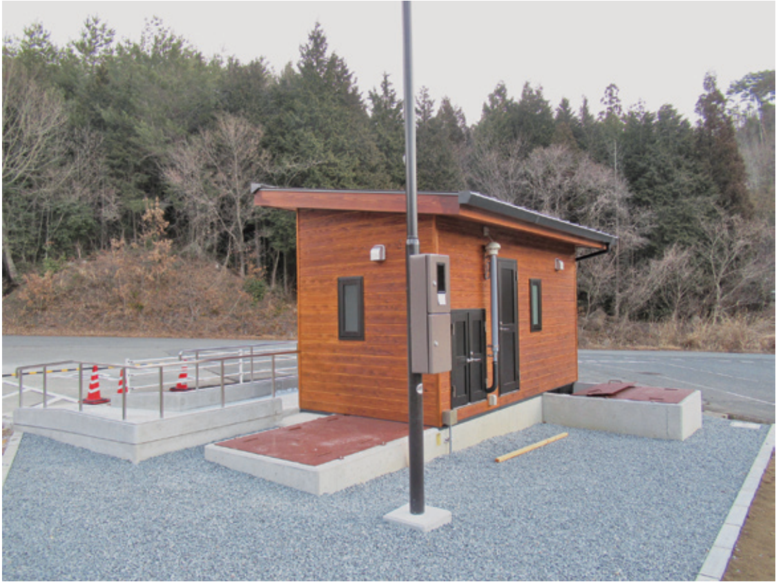
図版 4 a 久井岩海バイオトイレ（背面から）
