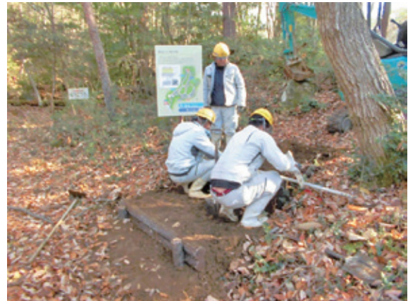
丸太階段工事 2
