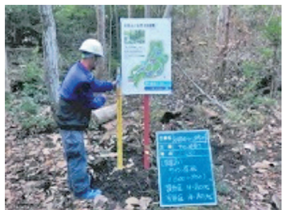
サイン取付工事 4
