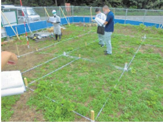
トイレ工事箇所確認
