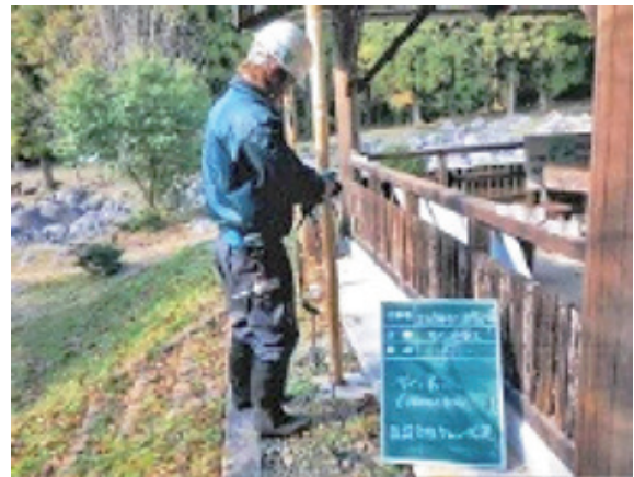
サイン取付工事 2
