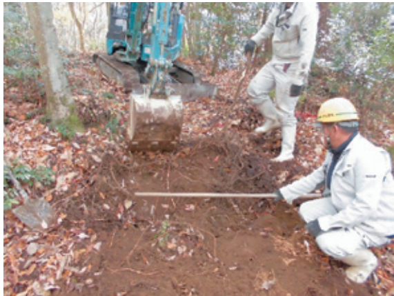
丸太階段工事 1
