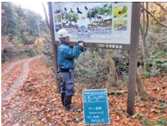
サイン取付工事 1
