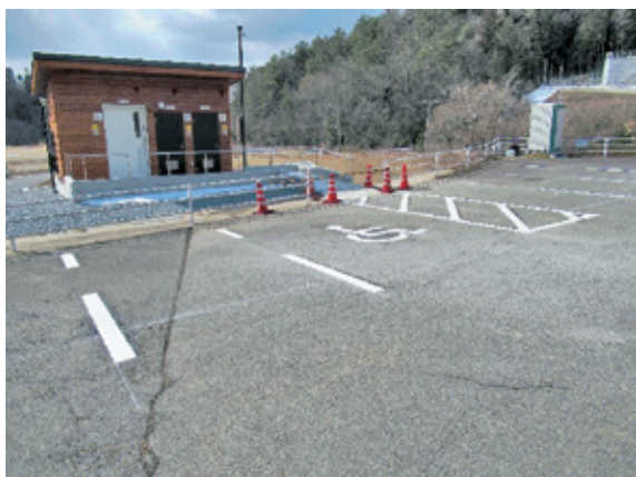
駐車線区画線完成 1
