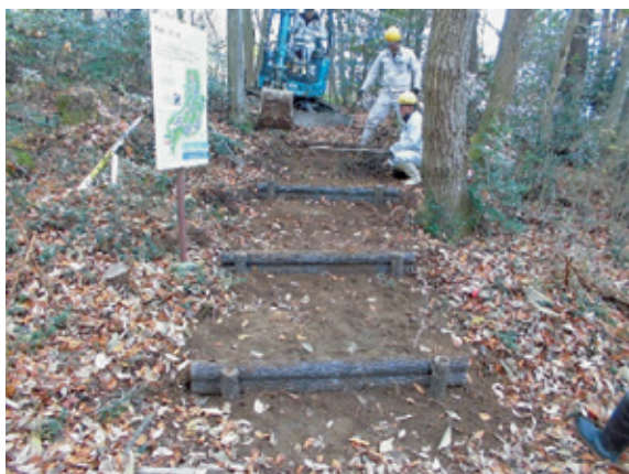
丸太階段工事 3
