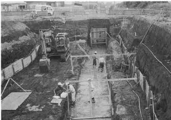
C区D区境現道下掘削工事作業風景 (谷)
