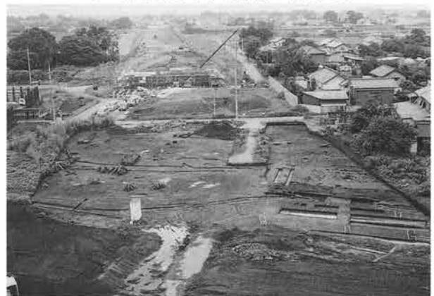
B-5・6区As-B下水田全景（西から）
