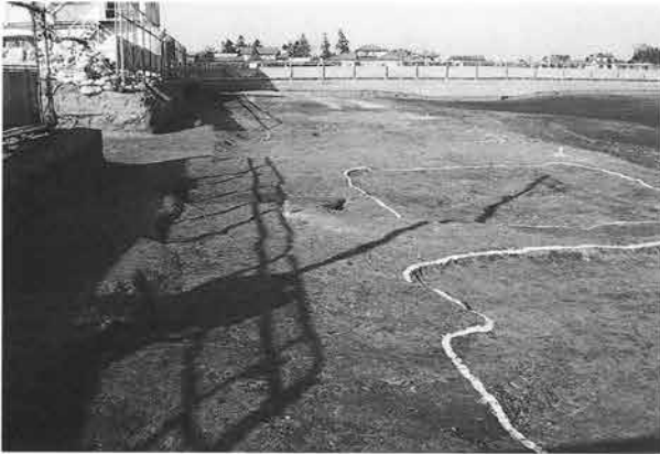
西微高地部段差
