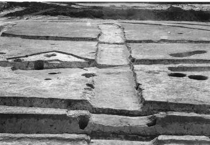
5 1区13号溝全景 (北東から)
