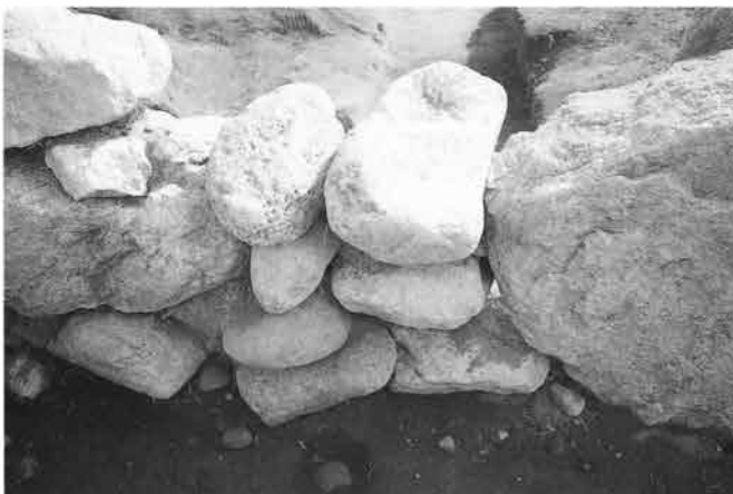
7. 石室：玄室東側壁石積み状況（西→）
