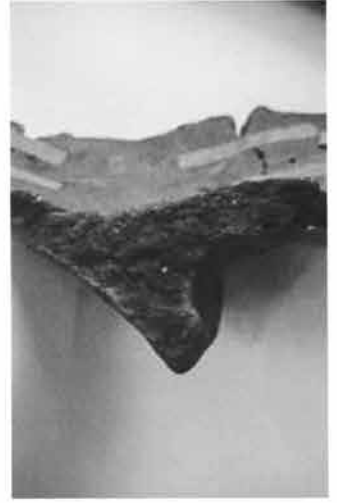
裾部と円筒部の接合状況
