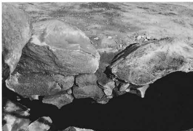
4. 石室：玄室東側壁石積み状況（西→）
