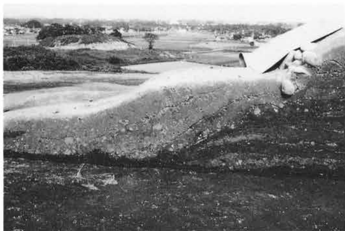
4. 墳丘：盛土断面 X-X' 石室北側 (西→)
