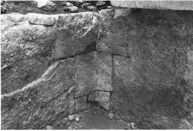
1. 石室：玄門北西隅 石組み状況（南東→）
