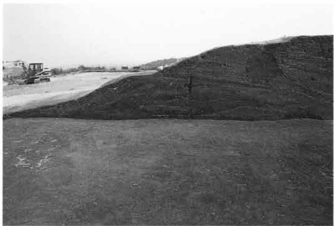
5. 墳丘：盛土断面 b-b' (南→)
