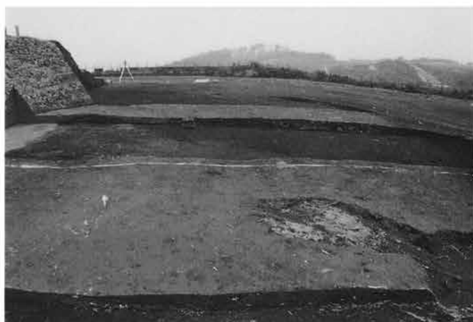
4. 墳丘：盛土断面 b-b' (南→)
