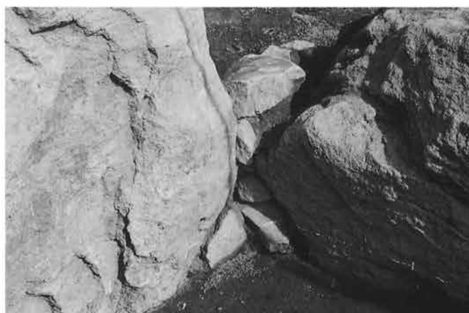
4. 石室：根石 玄室北東隅 (南西→)
