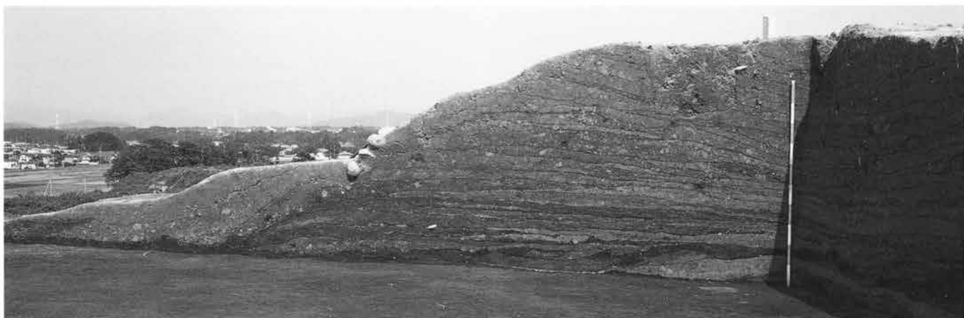
3. 墳丘：盛土断面 X-X' 石室北側 (西→)
