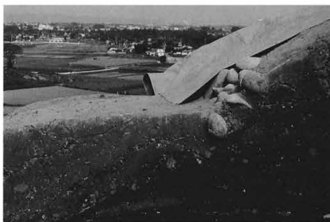
5. 墳丘：葺石設置部断面D-D'（西→）
