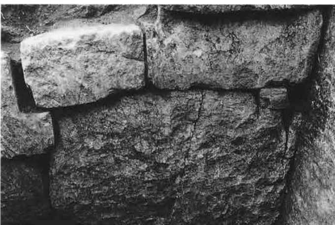
4. 石室：玄室東側壁 その2 (北西→)
