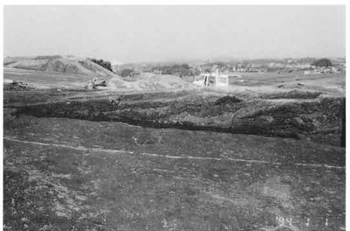
8. 墳丘：盛土断面Y-Y' 石室北側 (南西→)
