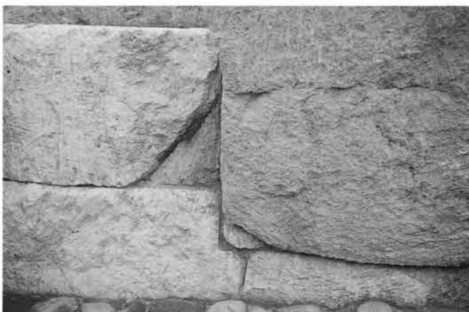
6. 石室：玄室東側壁 切組状況（南西→）
