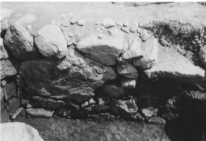
7. 石室：玄室東側壁 床石除去状況 (西→)
