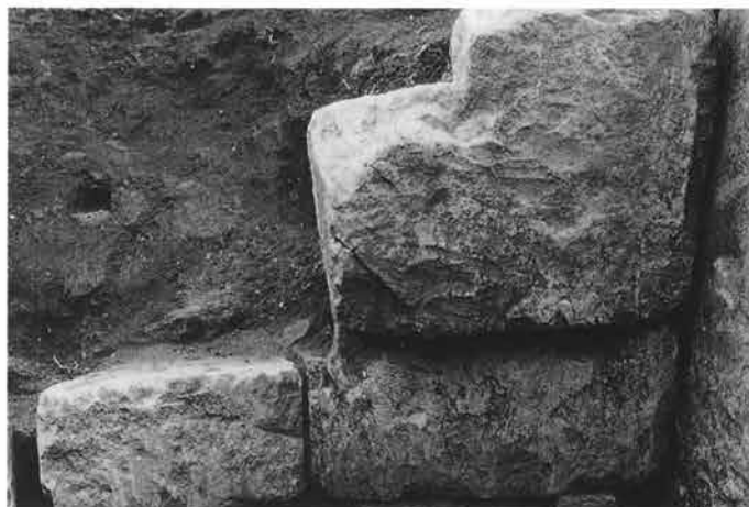
2. 石室：玄室東側壁 その1 (北西→)
