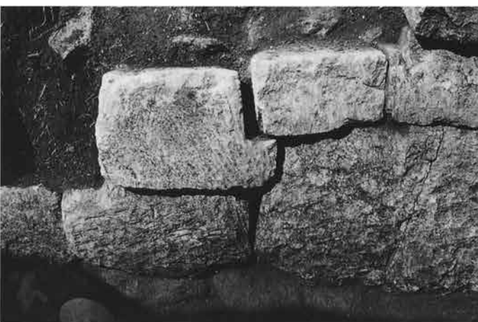
6. 石室：玄室東側壁 その3 (北西→)
