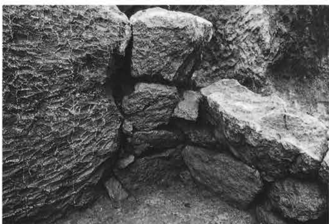
3. 石室：玄室 北東隅 石積み状況 (南西→)
