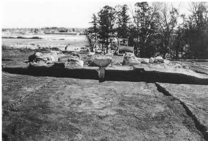
7. 墳丘：盛土断面 i-i' (西→)
