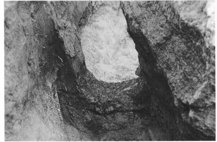
6. 石室：玄室 奥壁の背面設置状況（西→）
