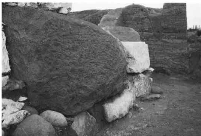
7. 石室：玄室東側壁の背面状況（南→）
