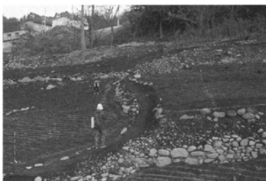
中棚Ⅱ遺跡Ⅴ区 集落と畑を結ぶ1号道は被災後もまず最初に復旧されたと考えられる。その根拠は現況の石垣が面を揃えて積み直されていることなどである。
