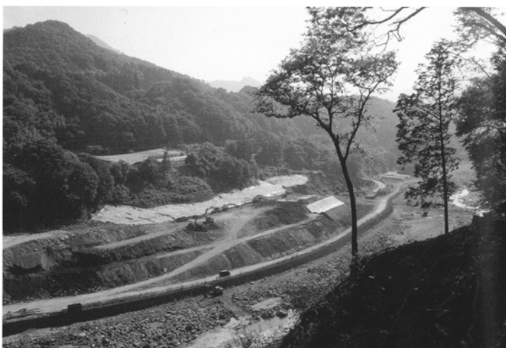
写真4. 中棚Ⅱ遺跡Ⅳ区 南西→。
