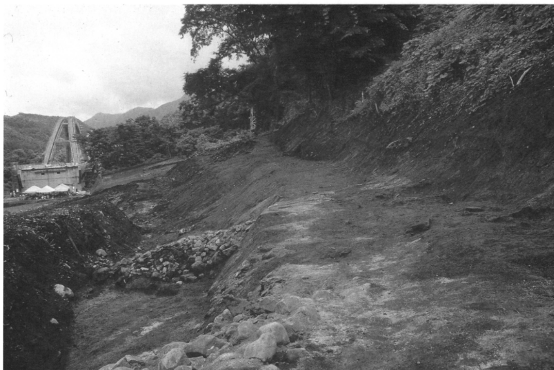
写真1. 久々戸遺跡 Ⅲ区草津みち(左奥は建設中の長野原めがね橋) 西→。
