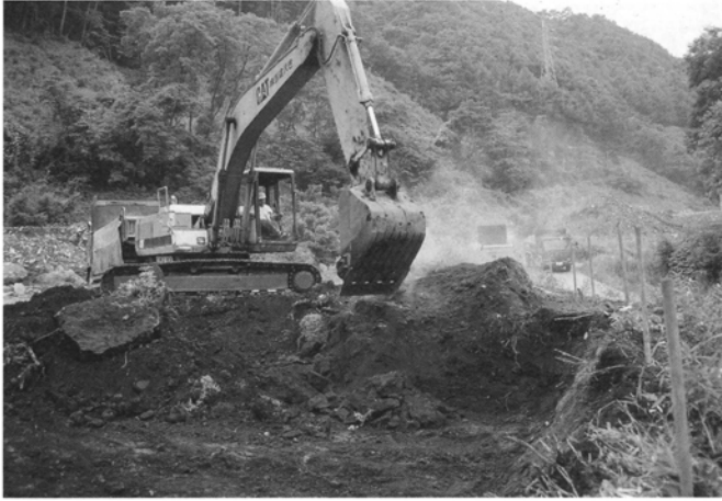
写真1. 久々戸遺跡 Ⅲ区表土掘削。
