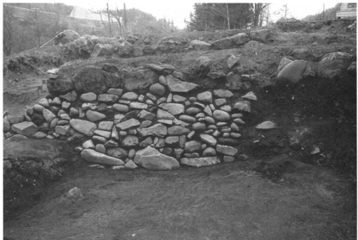
写真6. 中棚Ⅱ遺跡 II区2号石垣と直上位の現況石垣 東→。
