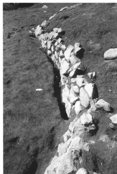
写真3. 下原遺跡 Ⅱ区泥流により移動した2号石垣 東→。
