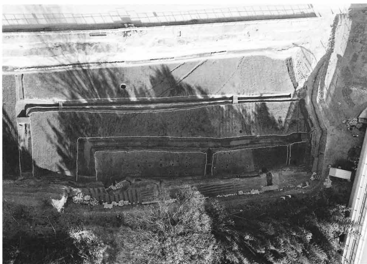
II区4面全景 上空より
