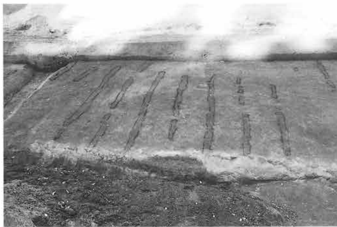
II区4面復旧島 南より
