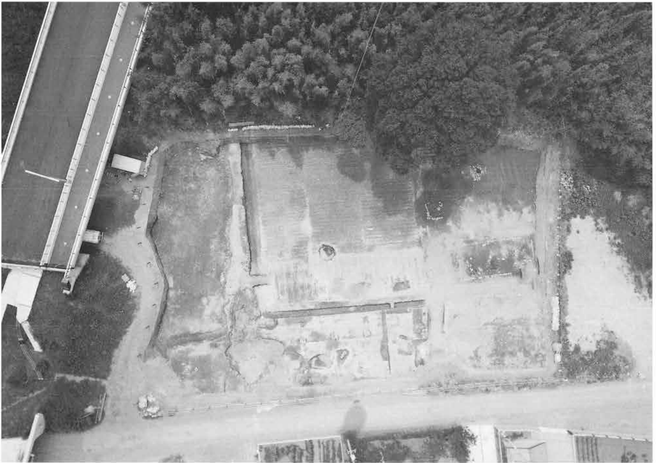
II区1面全景 上空より
