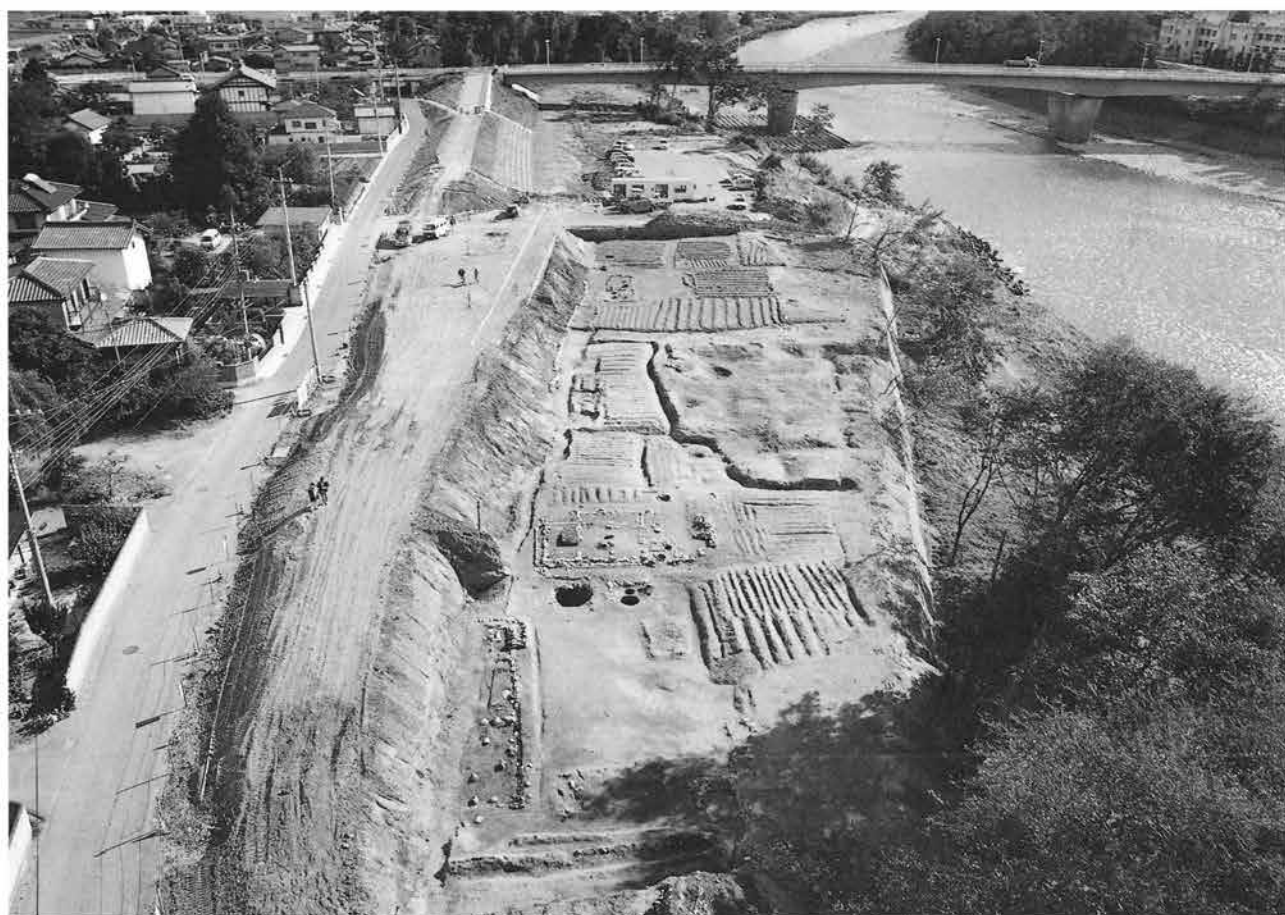
Ⅵ区1面全景 西より
