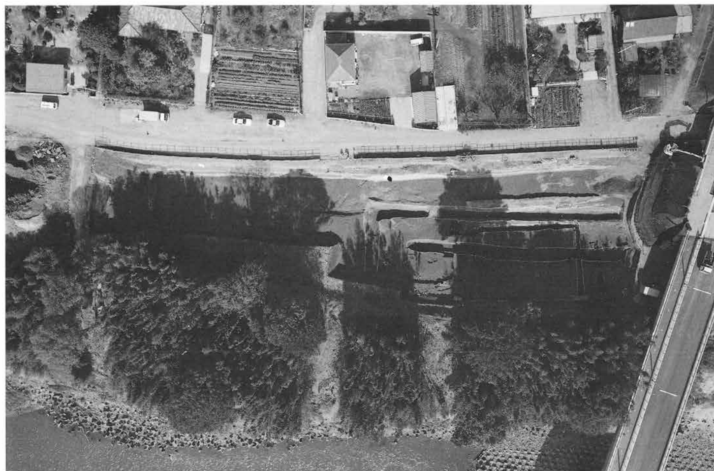
II区3面全景 上空より
