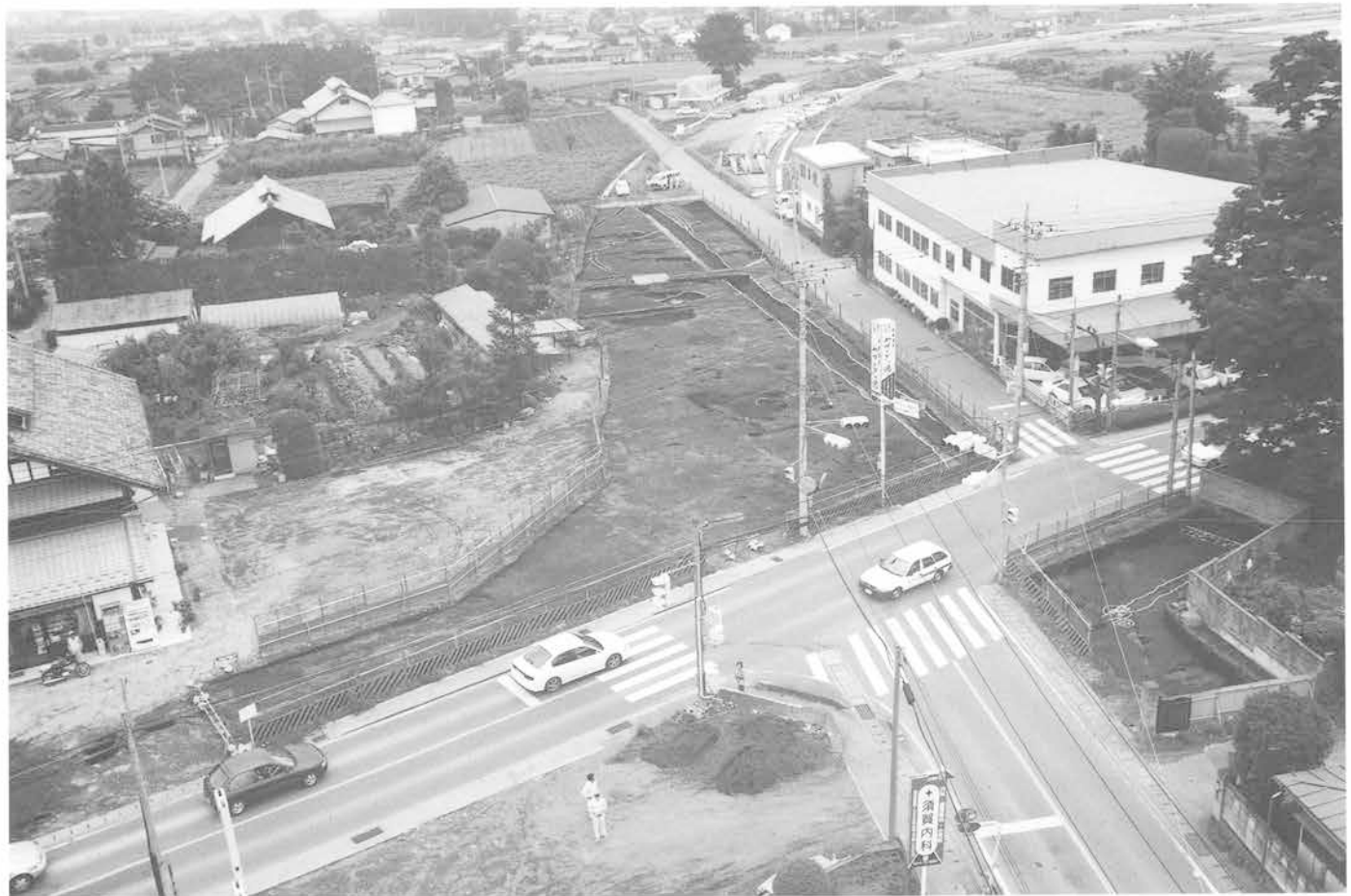
I区全景 斜め 北西から
