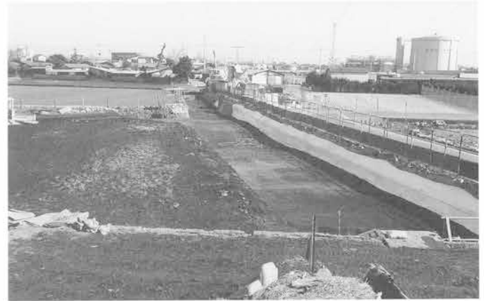
2区東V (Hr-FA) 層下全景 W→
