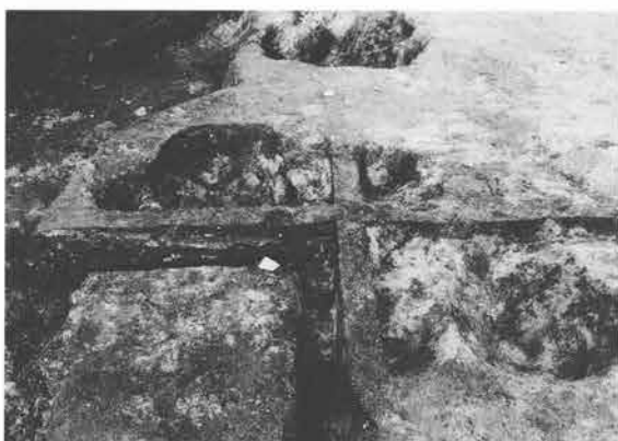
掘方調査状況
