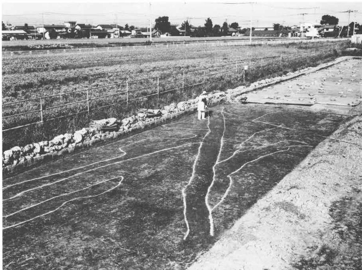
E区古代水田の二重畦の基部 付け替えではなく、当初から二重であったことが判明
