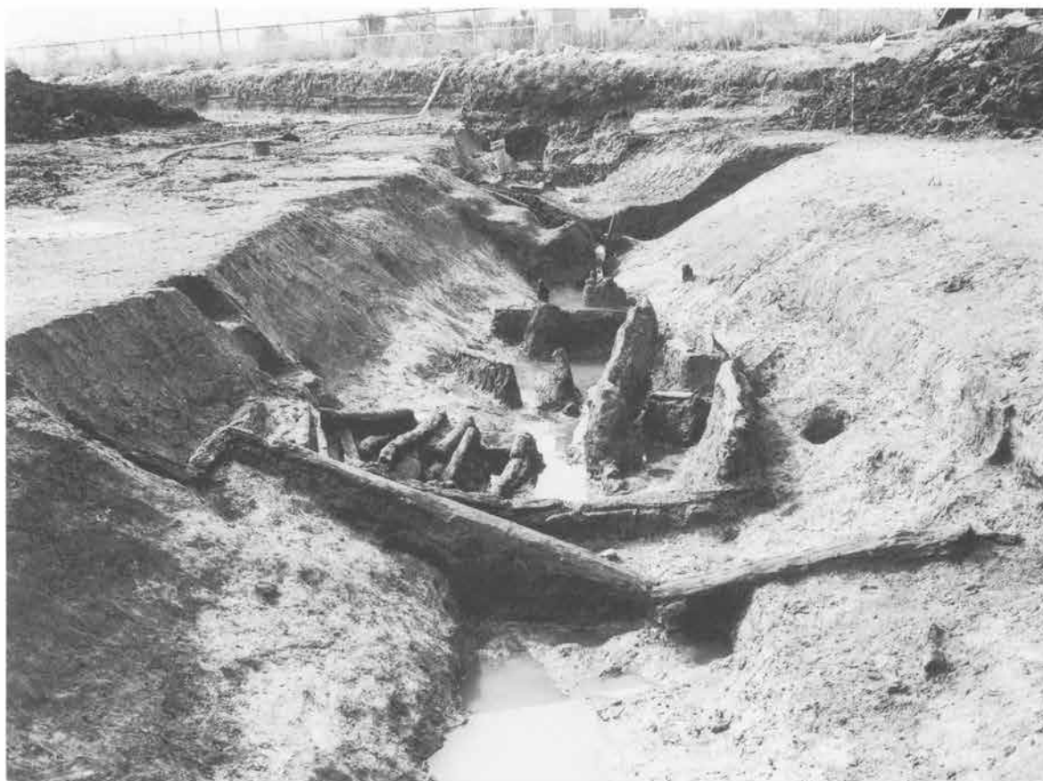
G区6号溝橋状遺構 溝を横断する長い橋桁材と横木で構成される
