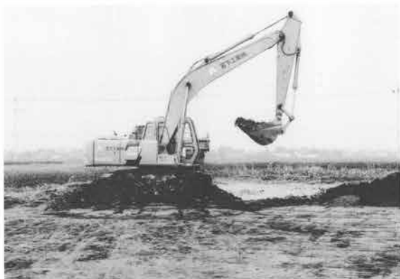
重機による表土掘削作業
