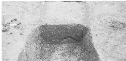
8. A区第5面40号溝断面
